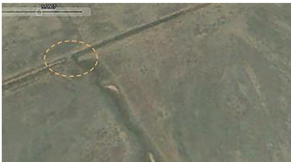
Рисунок 1. Место разрыва канала и утечки отходов переработки йодо-бромных вод
