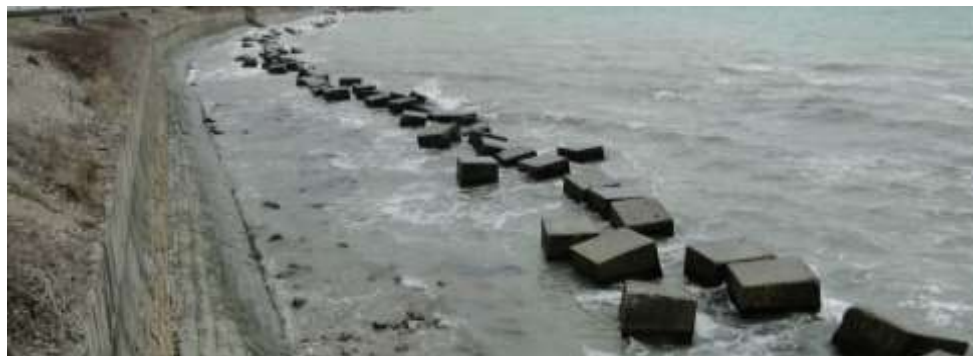
Рисунок 5. Прерывистый волнолом
