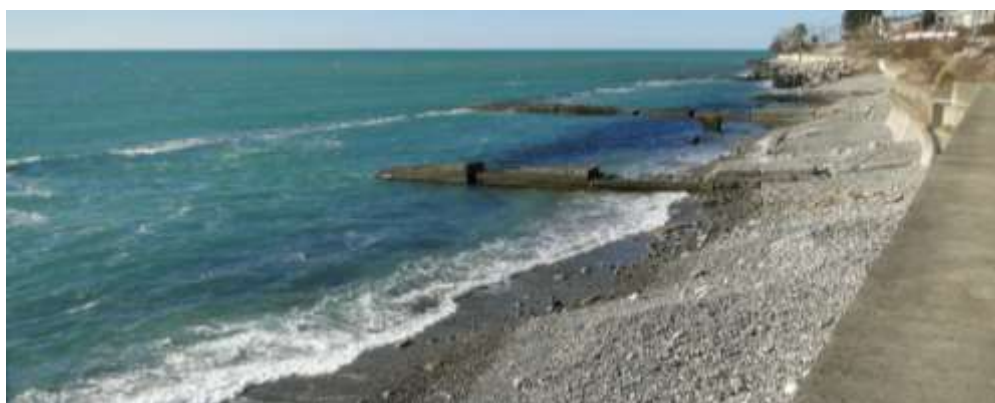
Рисунок 4. Волнолом «кавказского» типа
