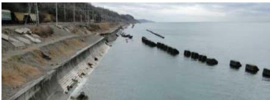
Рисунок 5. Прерывистый волнолом
