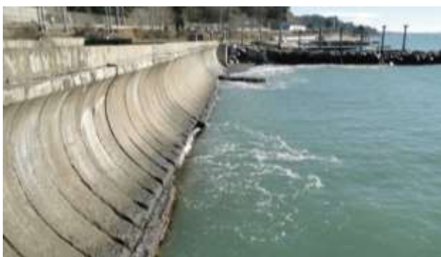
Рисунок 1. Подпорно-волноотбойные стены: а — бетонные монолитные; б — сборной конструкции; в — откосно-ступенчатого типа
