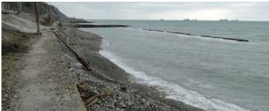
Рисунок 3. Г-образный волнолом с траверсой
