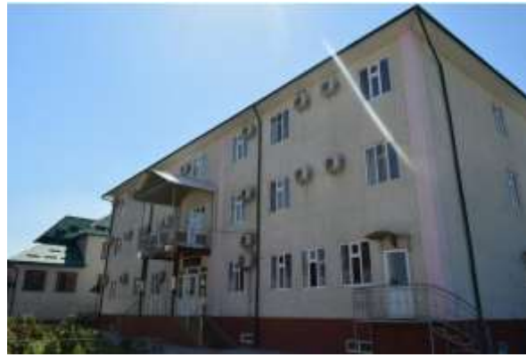
Рисунок 4. 3-этажный дом по улице Исанова
