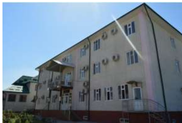
Рисунок 4. 3-этажный дом по улице Исанова
