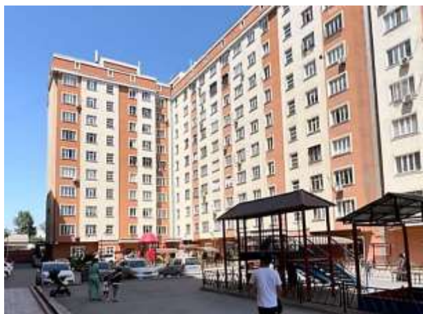
Рисунок 7. 9-этажный дом по улице Алайская
