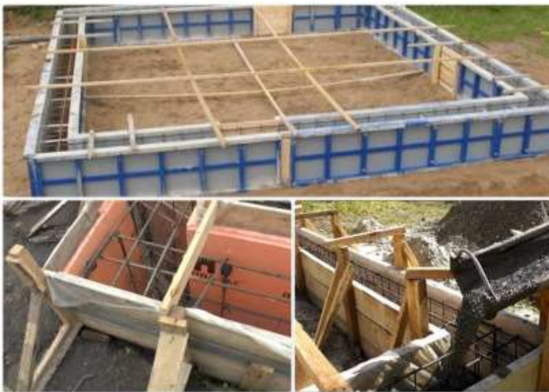
Рисунок 4. Установка опалубки для фундамента
