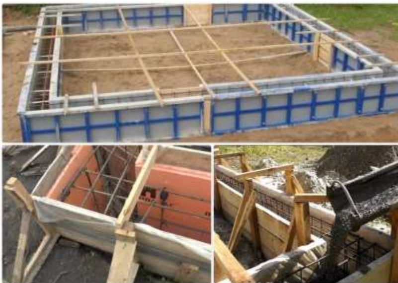
Рисунок 4. Установка опалубки для фундамента
